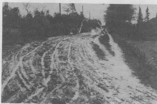
Tütjenbarg vor der Pflasterung
