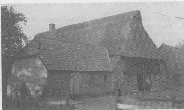
Ansicht des Heinje-Hofes vor dem Umbau
